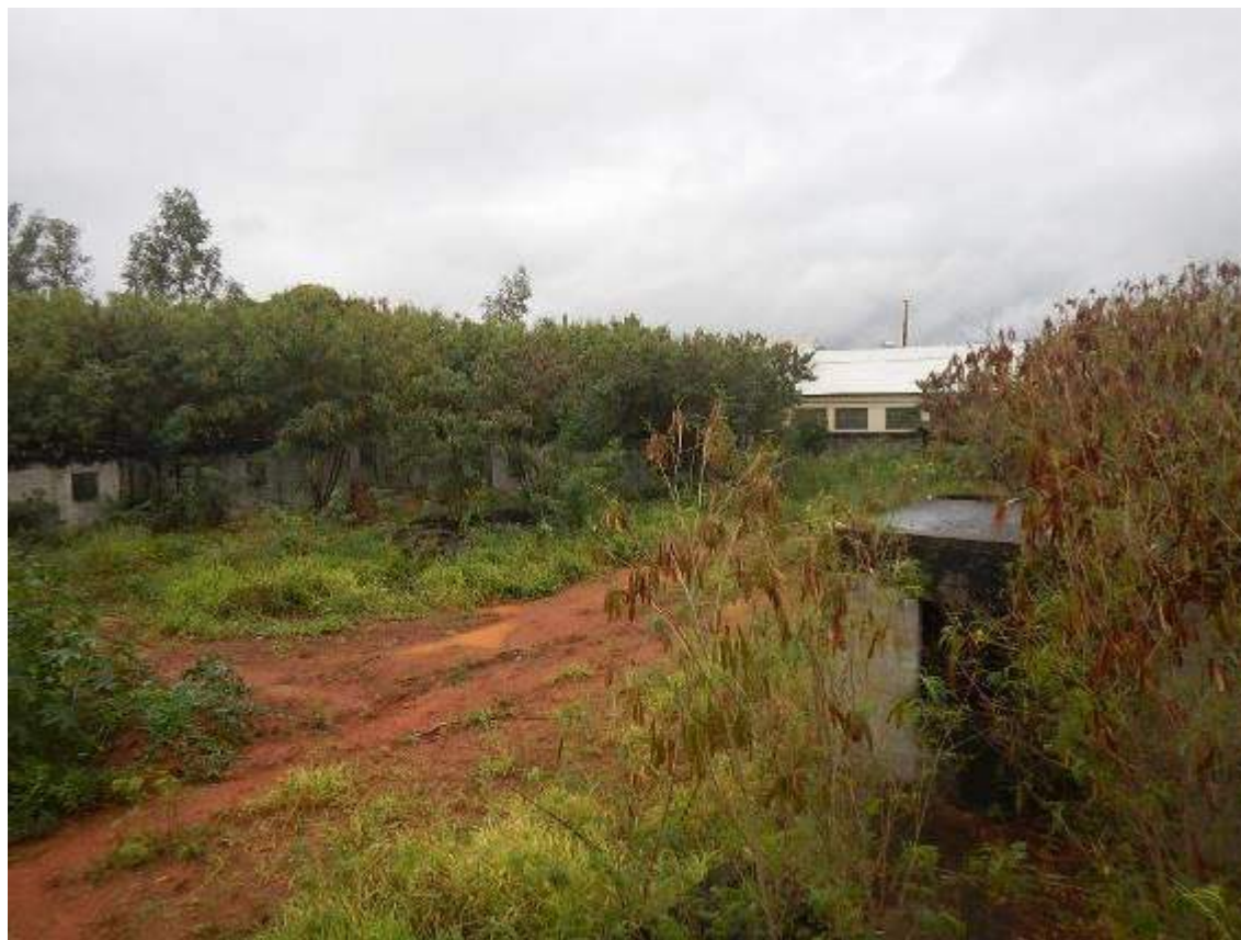
VISTA DOS FUNDOS DO TERRENO, PODENDO-SE NOTAR AS CONSTRUÇÕES PARALISADAS DOS BLOCOS 2, 5 E 6.
