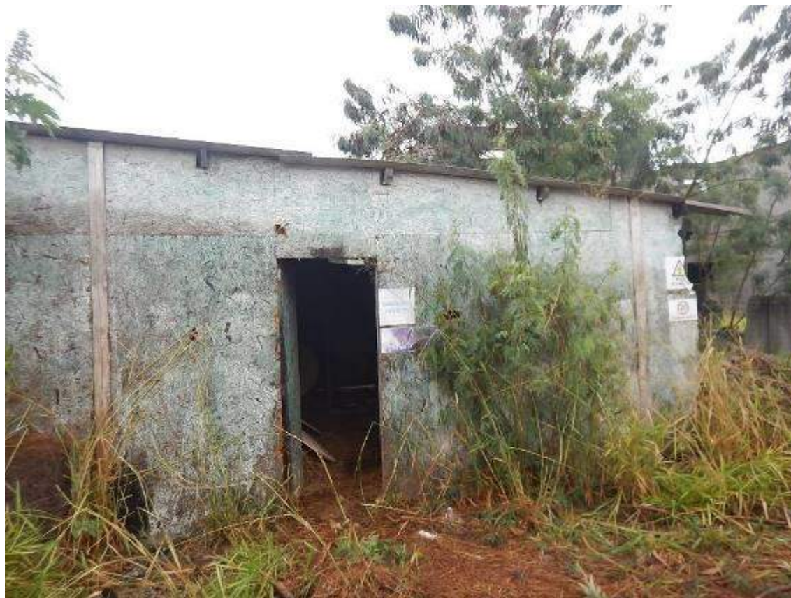
DEPÓSITO DE MATERIAIS E FERRAMENTAS.
