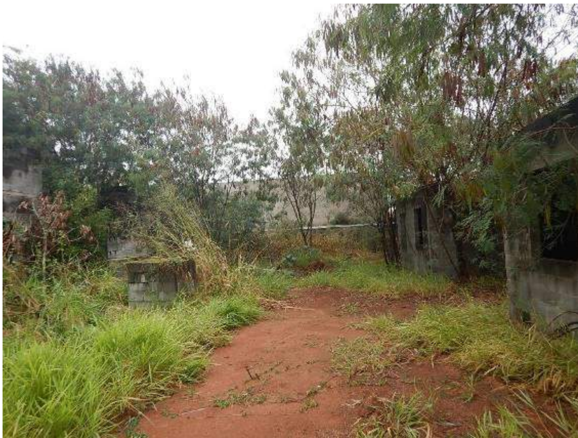
ÁREA DE CIRCULAÇÃO ENTRE OS BLOCOS 10 E 11.
