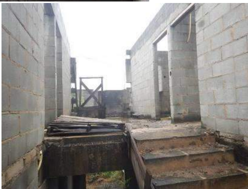
ESCADA DO BLOCO 1.
