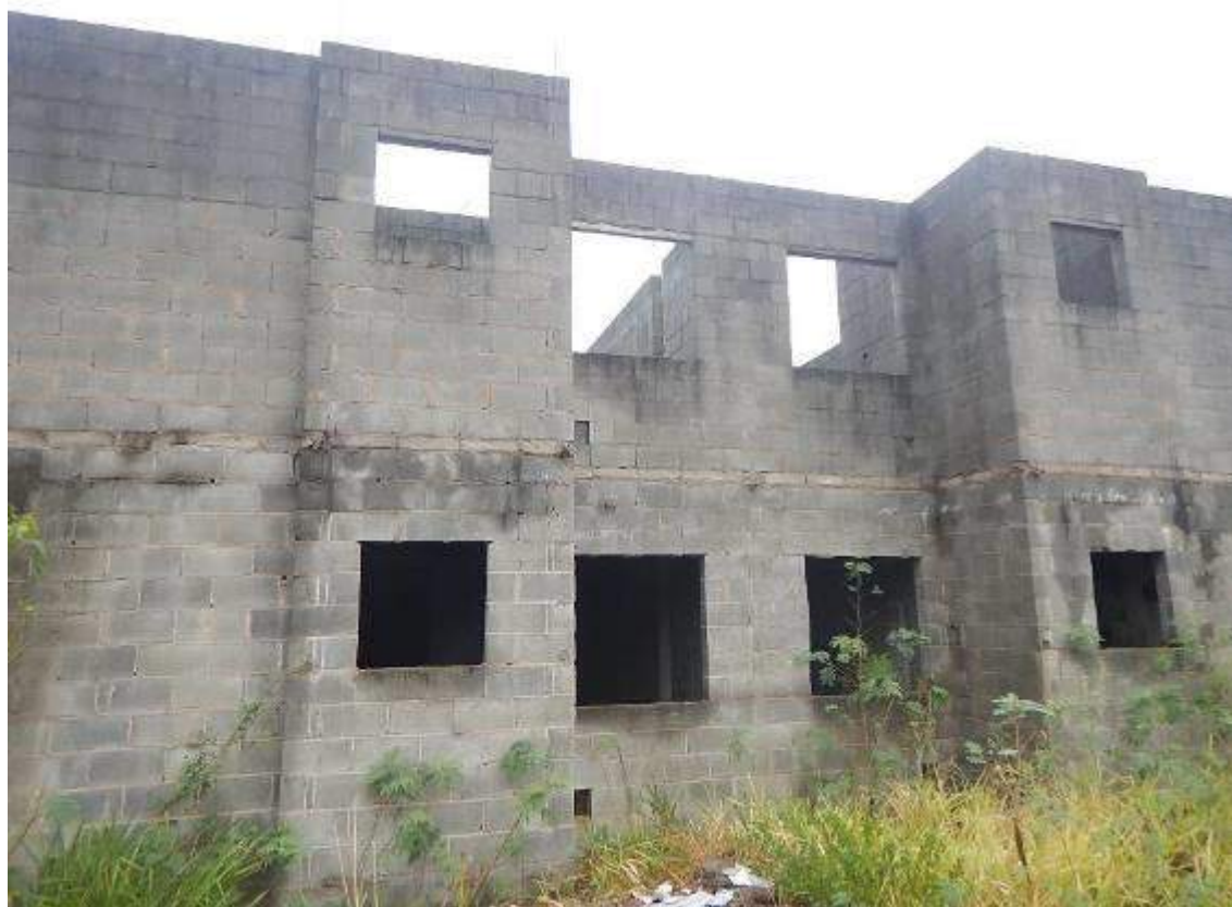
OUTRA VISTA DO BLOCO 1, INACABADO.
