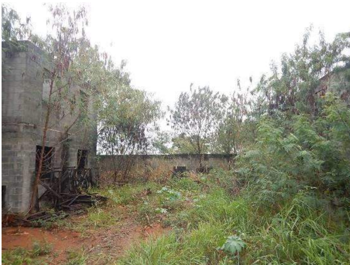
MURO DE DIVISA DO EMPREENDIMENTO.
