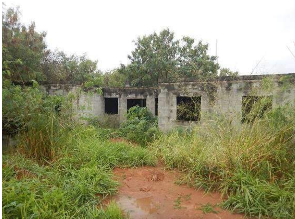
VISTA DO BLOCO 6.
