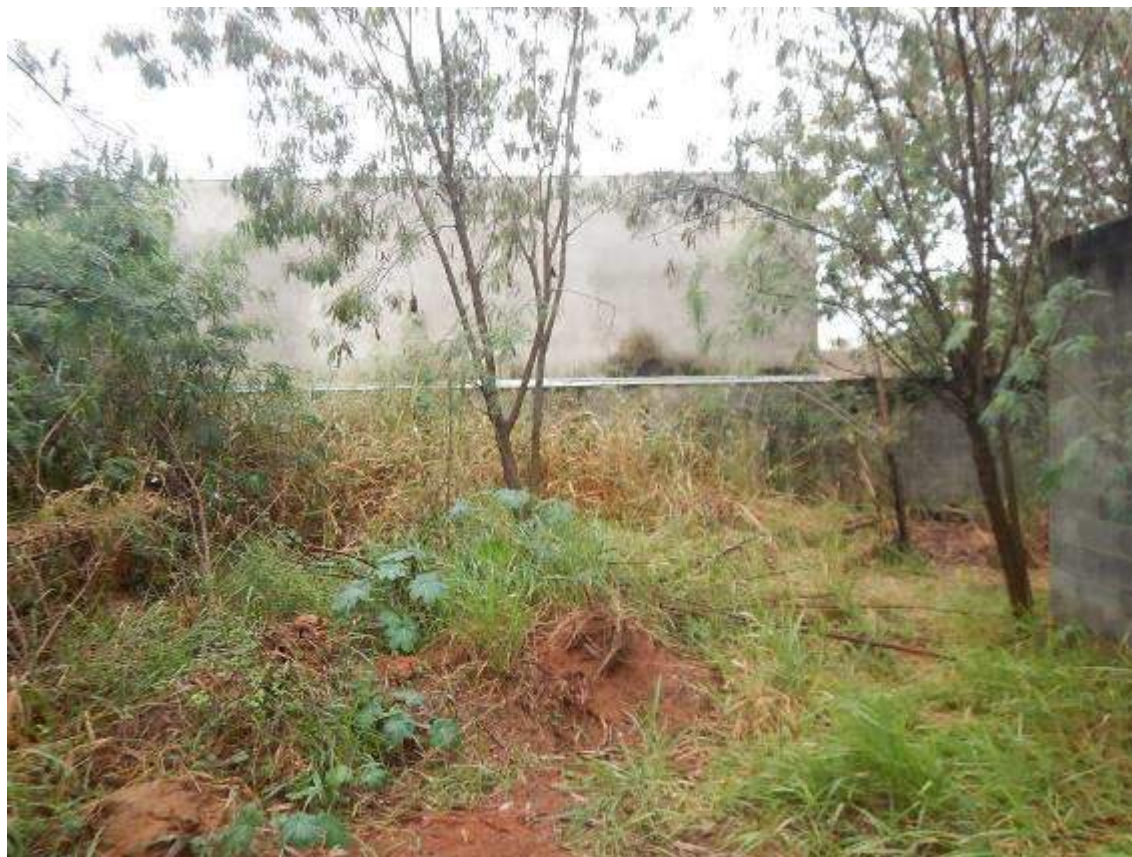
MURO DE DIVISA DO EMPREENDIMENTO.
