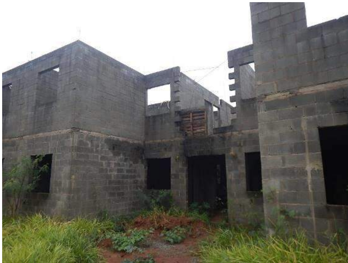
VISTA DO BLOCO 12.
