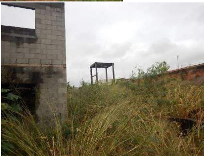
VISTA E DETALHE DO SUPORTE DA CAIXA D'ÁGUA PROVISÓRIA, RETIRADA DO LOCAL.
