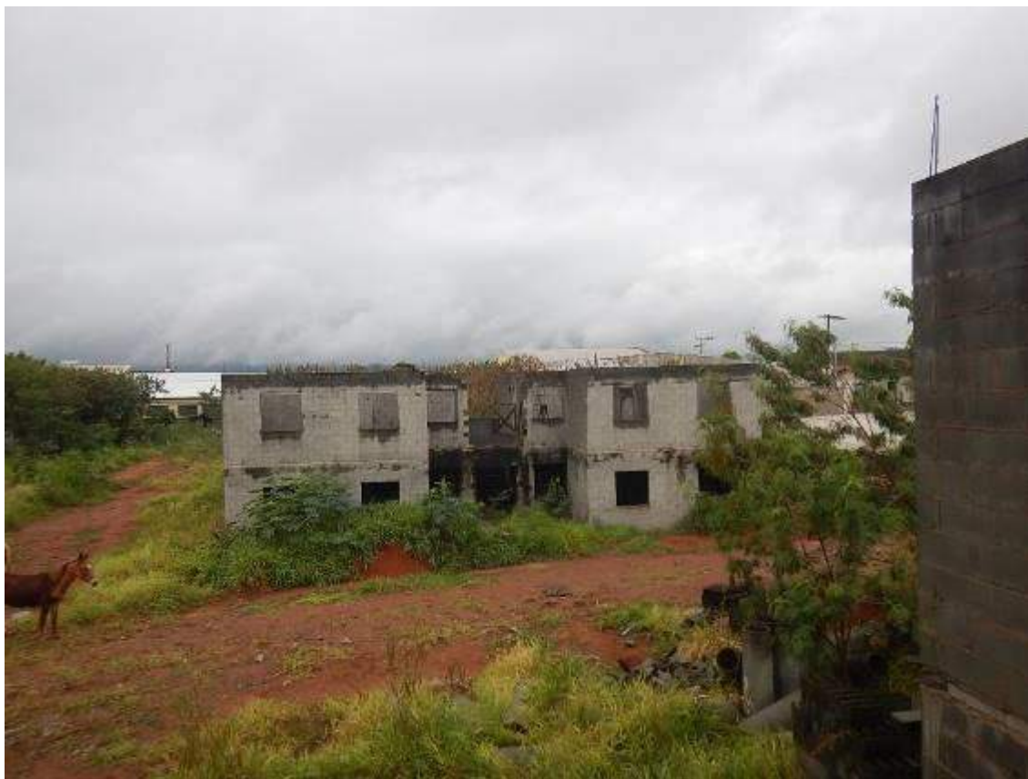
BLOCO 6 VISTO A PARTIR DO BLOCO 1.
