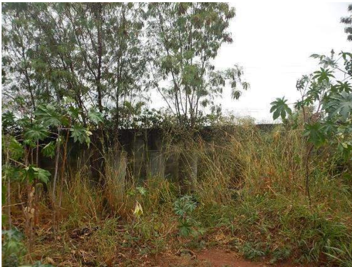
MURO DE DIVISA DO EMPREENDIMENTO.
