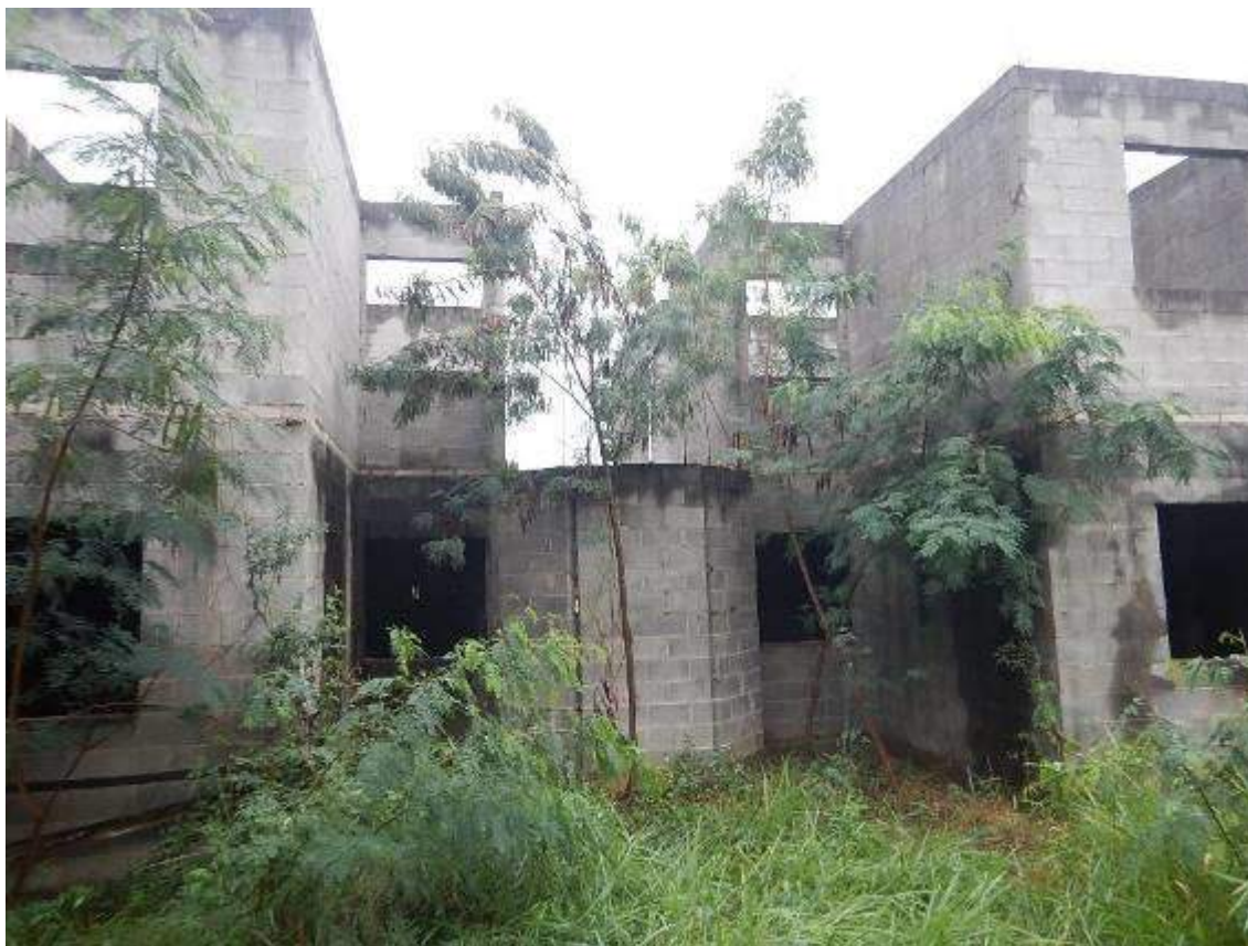
VISTA DO BLOCO 8.
