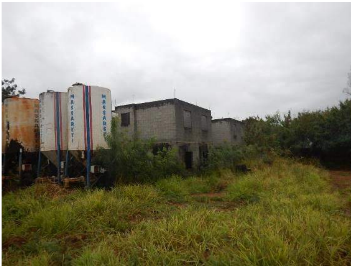
VISTA DO BLOCO 7.
