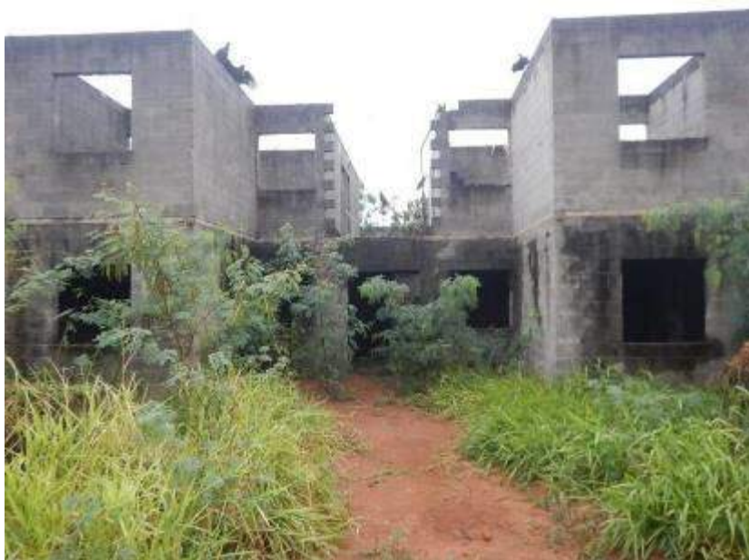
OUTRA VISTA DO BLOCO 12.
