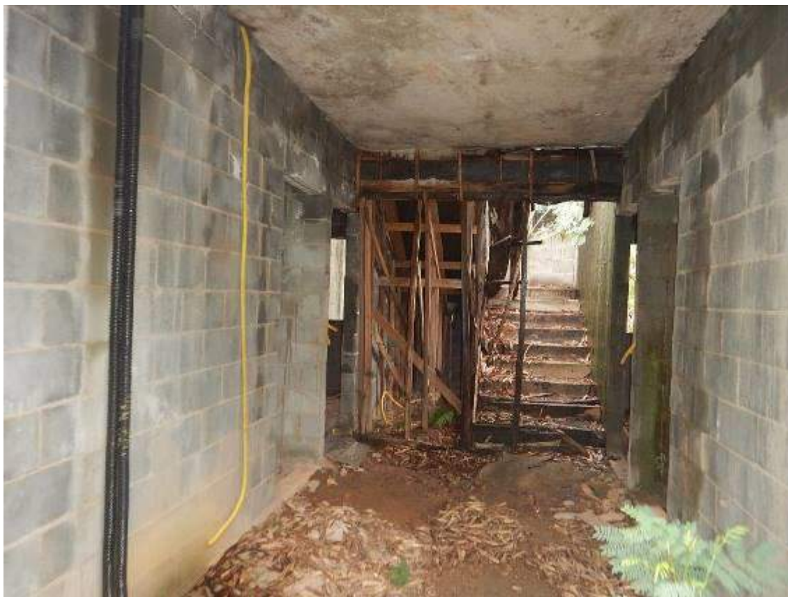
VISTA INTERNA DO BLOCO 11.
