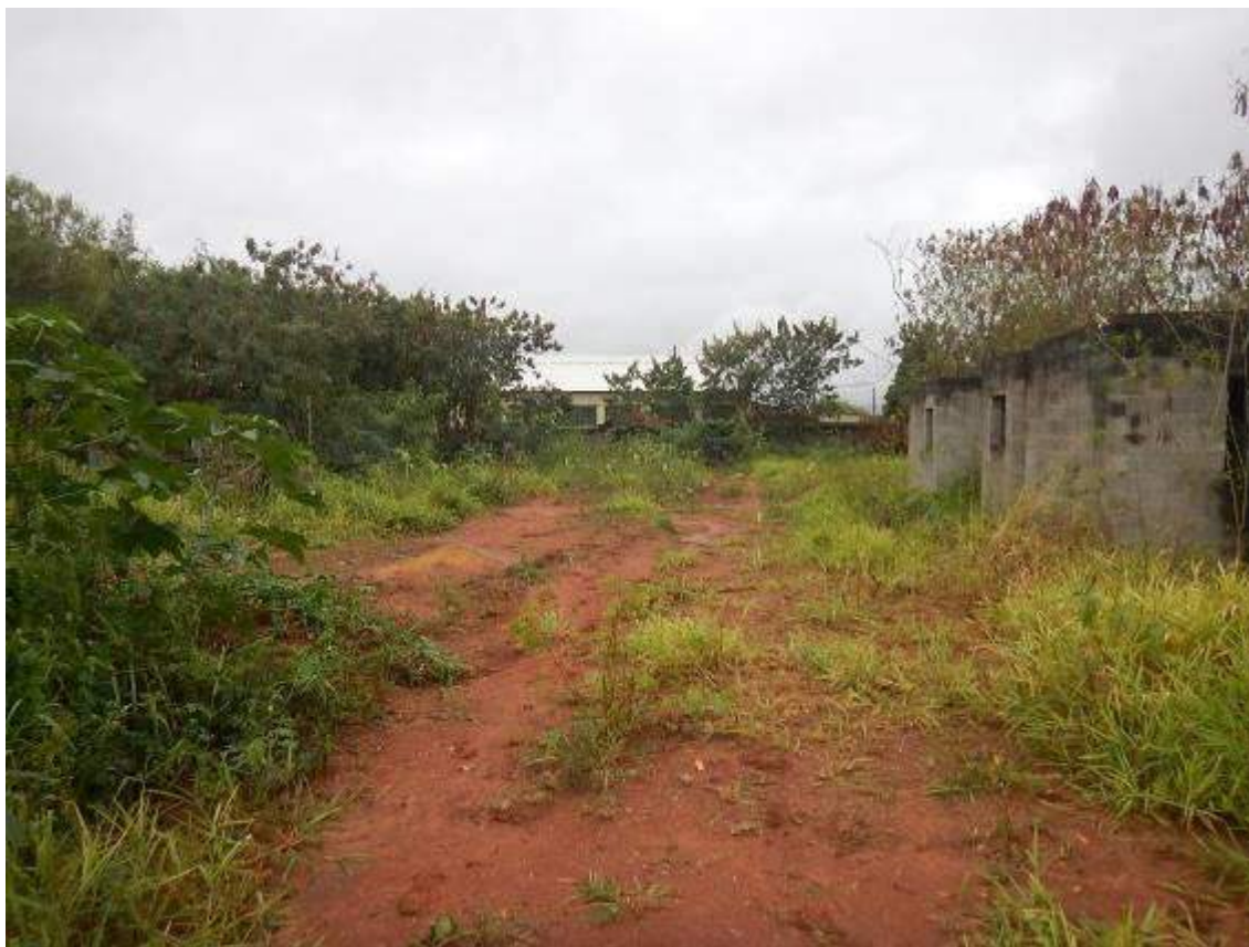
VISTA DA ÁREA DE CIRCULAÇÃO ENTRE OS BLOCOS, SEM PAVIMENTAÇÃO.
