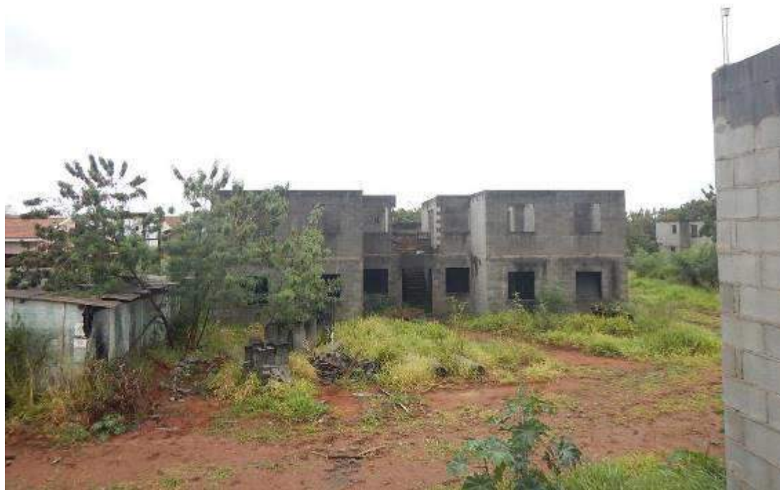
BLOCO 12 VISTO A PARTIR DO BLOCO 1.
