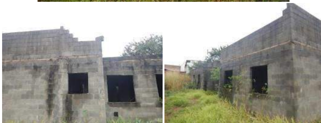
VISTA DO BLOCO 10.
