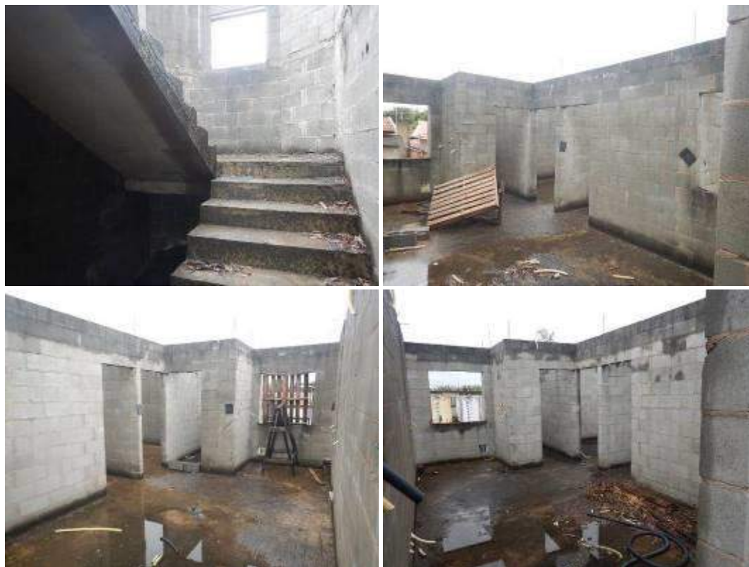
MAIS VISTAS DO BLOCO 12.
