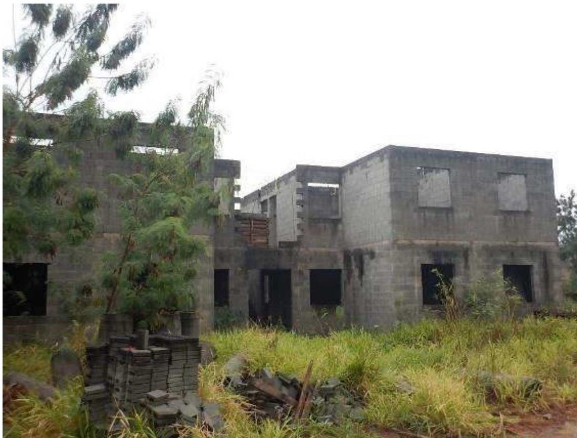
VISTA DO BLOCO 12, INACABADO.
