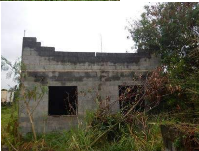
MAIS VISTAS DO BLOCO 11.
