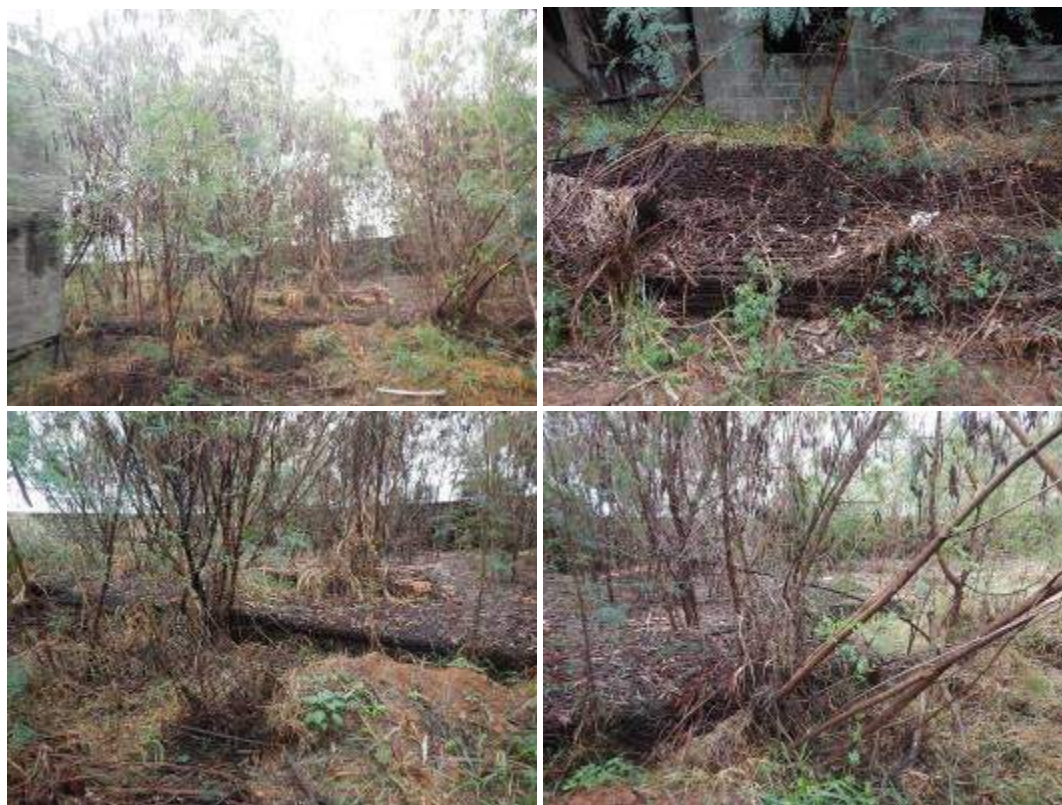
DETALHES DE MATERIAIS ABANDONADOS NA OBRA: TELAS DE ARMADURA PARA LAJES, SEM POSSIBILIDADES DE USO, DADO O AVANÇADO ESTADO DE CORROSÃO.
